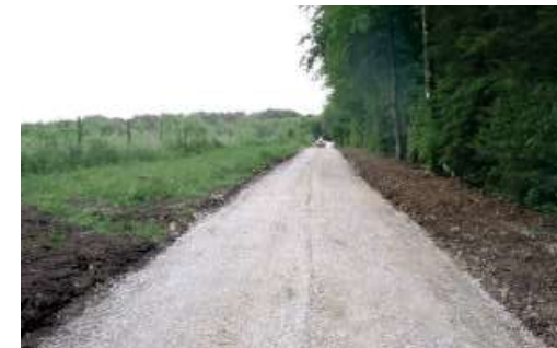
Photographie 173 : Texture des pistes en concassé granit (source : RES)
