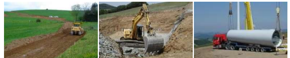
Photographie 174 : Illustration d'un chantier éolien
